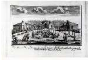
SaMB.III, Morgenländischer Bau, Joh.Th.Köppel, DE003014, BSV
